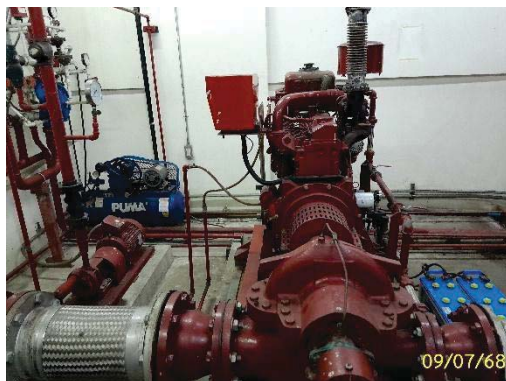
ชุดเครื่องสูบน้ำดับเพลิง
