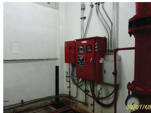
ชุดเครื่องสูบน้ำดับเพลิง
